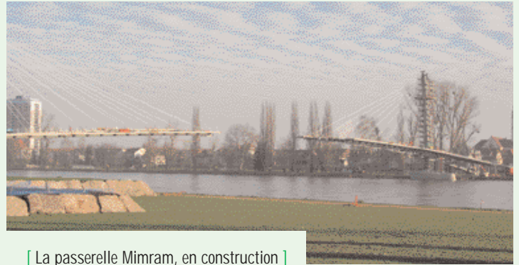
[ La passerelle Mimram, en construction ]
